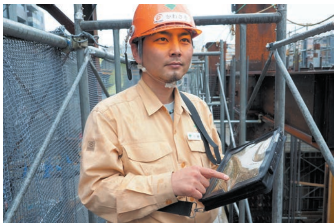
東京都内のビル工事現場でiPad対応のデジタル野帳「eYACHO」を活用する大林組の川崎亮太さん
