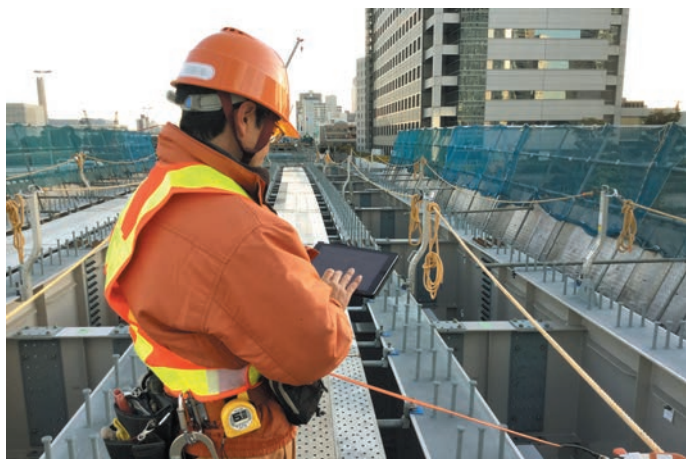
首都高羽田1号線のリニューアル工事でデジタル野帳「eYACHO」を活用する大林組JVの施工管理技術者
